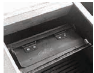
Rauchrichter (17) geöffnet ⇒ die Kesselleistung wird deutlich reduziert
